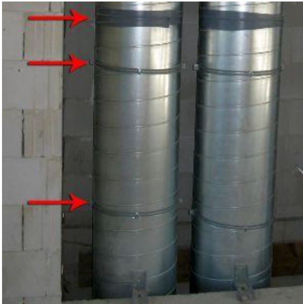
Afb. 6.3 Tapes verbinding en beugelen luchtkanalen
