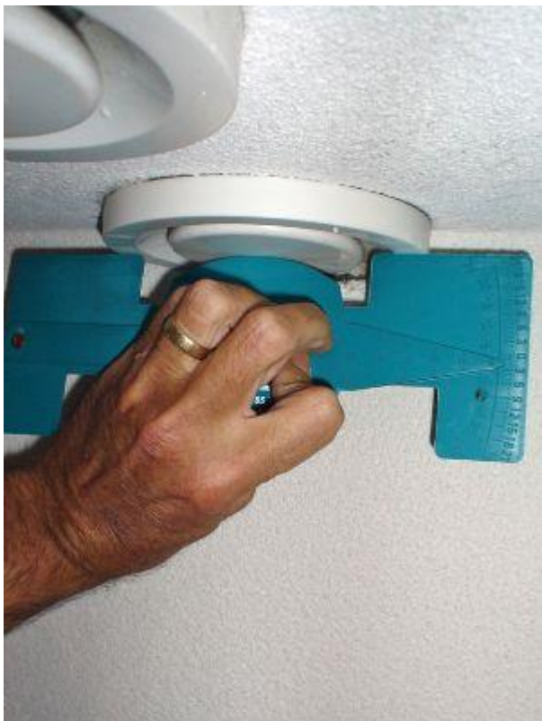
Afb. 6.11 Instellen lucht volumestroom ventiel met speciale liniaal
