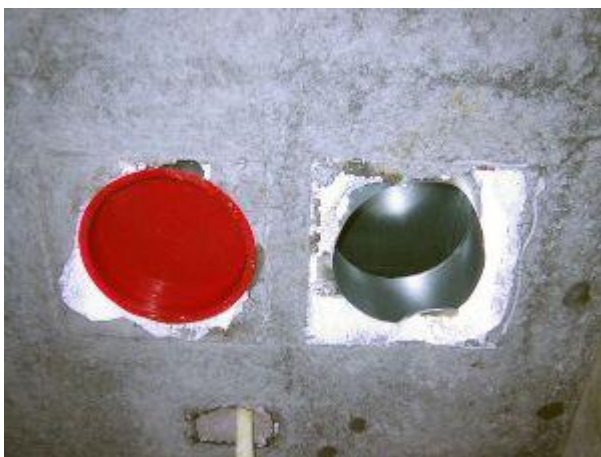
Afb. 6.5 Eindkap op ingestort luchtkanaal
