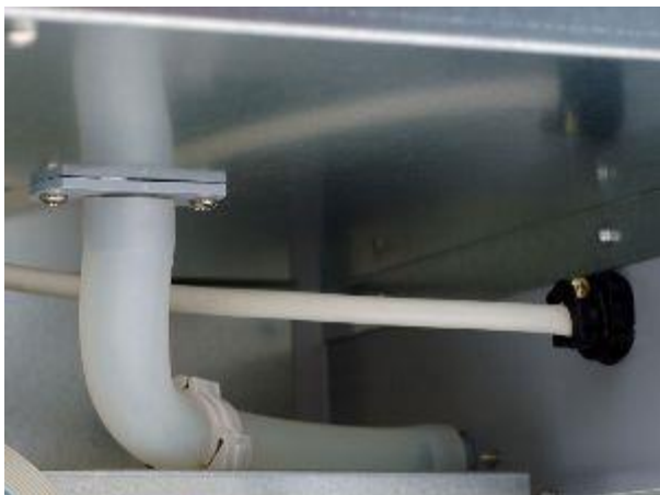
Afb. 5.16 Condensaatafvoer WTW-unit
