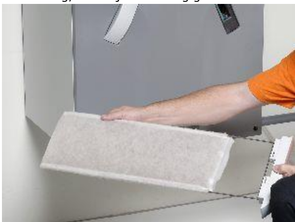
Afb. 7.9 Vervangen luchtfilters (grof filter) in een WTW-unit
