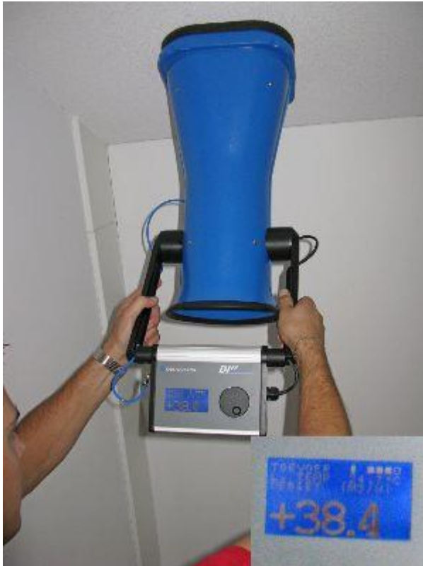
Afb. 6.9 Lucht volumestroom van een ventiel meten met een nuldruk compenserende volumestroommeter
