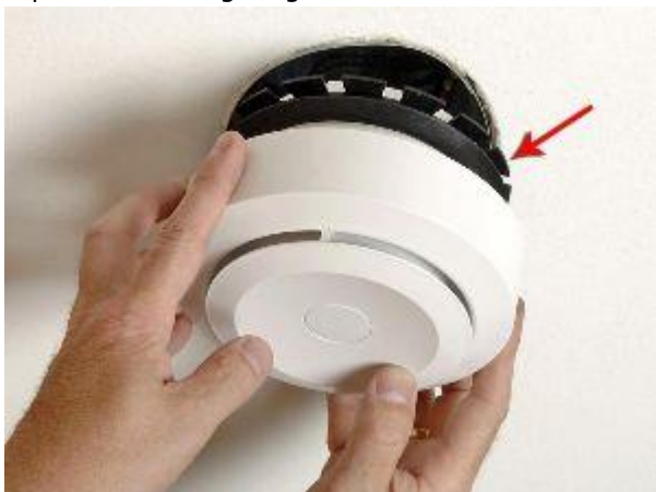
Afb. 6.2 Afdichtingsringen op (toevoer)ventielen
