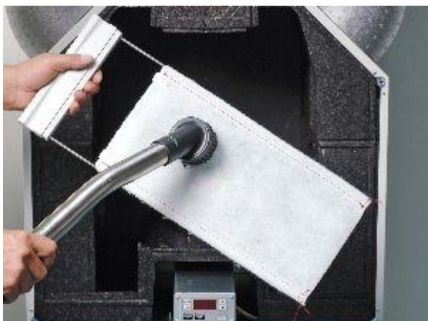
Afb. 7.8 Luchtfilters uitzuigen Regulier gebruik woning
